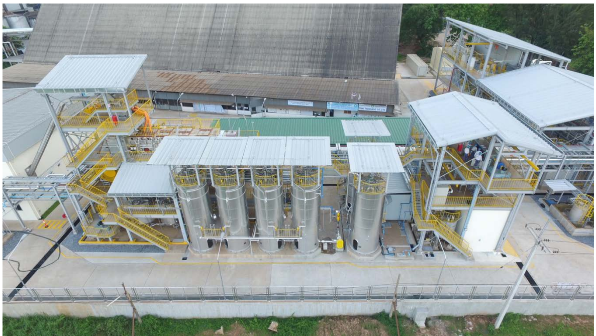
図1 完成した実証プラントの全景
